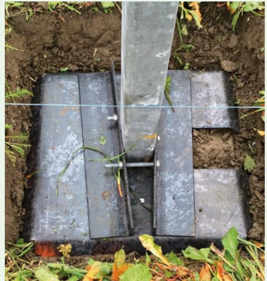
**Achtung! Bei Ankerabständen unter 1,5 Meter ist eine Zusatzklemmung erforderlich.**
